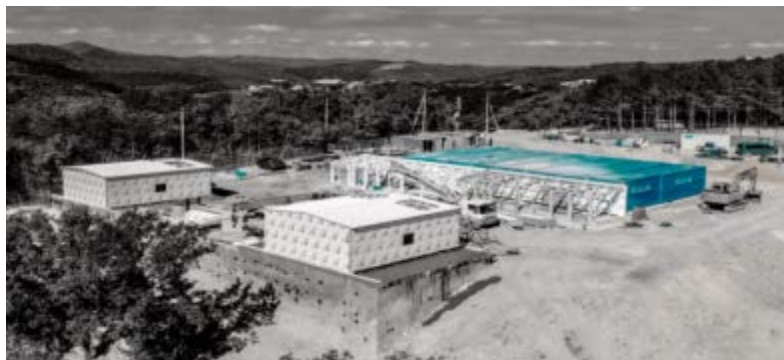
С. АБРАУ-ДЮРСО КРАСНОДАРСКИЙ КРАЙ Оборудование ЛОС-МБР-3000 на основе мембранного биореактора
