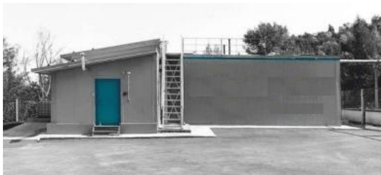
С. БОГАТЫРЬ САМАРСКАЯ ОБЛАСТЬ Станция очистки сточных вод производительностью 200 м 3 /сут
