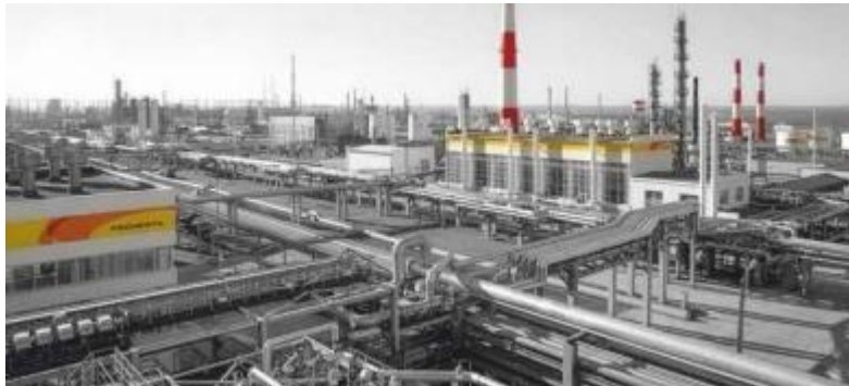
Г. СЫЗРАНЬ, САМАРСКАЯ ОБЛАСТЬ НК «РОСНЕФТЬ», «СЫЗРАНСКИЙ НПЗ» Сооружения биохимической очистки производительностью 24 000 м 3 /сут
