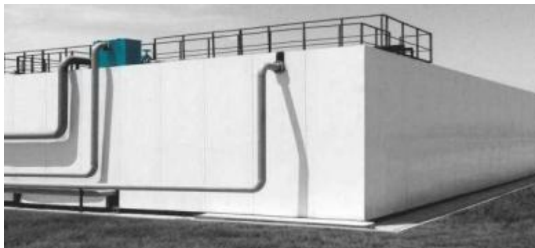
Г. АКТОБЕ РЕСПУБЛИКА КАЗАХСТАН Станция очистки сточных вод производительностью 3 000 м 3 /сут
