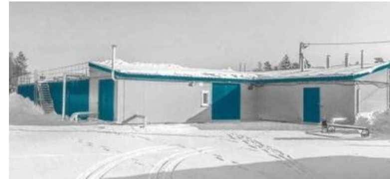
Д. ЖИЛЕТОВО КАЛУЖСКАЯ ОБЛАСТЬ Оборудования ЛОС-Р-800 для хозяйственно-бытового
