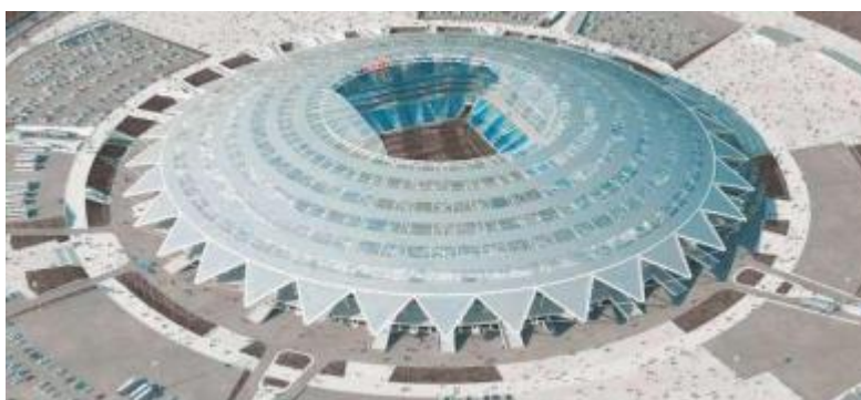
Г. САМАРА, САМАРСКАЯ ОБЛАСТЬ СТАДИОН «САМАРА АРЕНА» Станция очистки сточных вод производительностью 10 700 м 3 /сут
