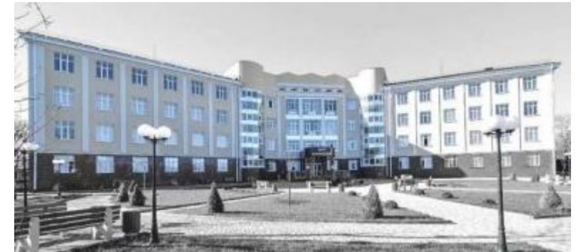
Г. ГОРБАТОВ, ЦЕНТР ВОССТАНОВИТЕЛЬНОЙ МЕДИЦИНЫ И РЕАБИЛИТАЦИИ МВД РОССИИ Станция очистки сточных вод производительностью 100 м 3 /сут
